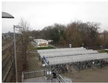
Fahrradabstellanlagen auf der Nordseite
